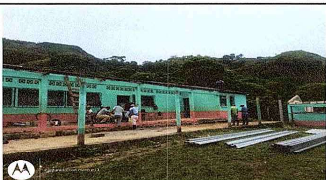
Foto 5: Instalación de estructura para entechado
